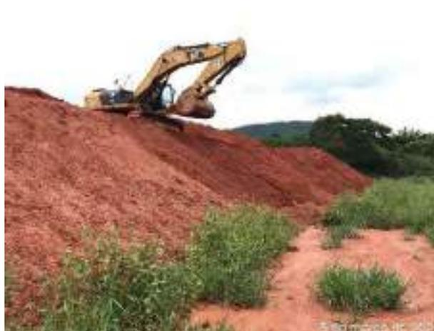
**Foto 233** – Compactação de taludes bota espera. (Data:05/03/2021)
