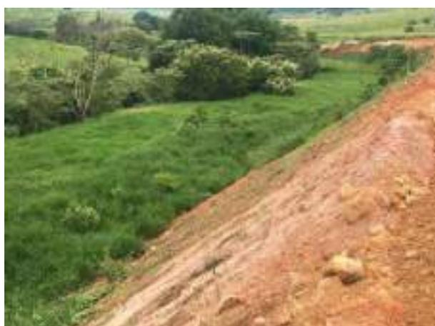
**Foto 238** – Cobertura de talude do Bota Fora com material vegetal. (Data: 10/03/2021)
