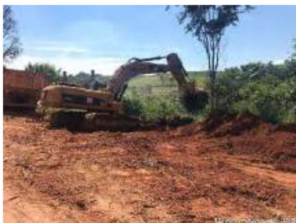
**Foto 231** – Leira para proteção e disciplinamento das águas pluviais. Data:10/03/2021)
