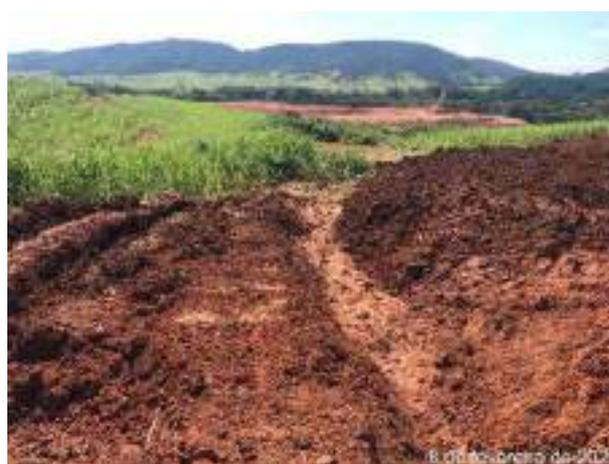
**Foto 225** – Canaleta para direcionamento das águas pluviais próximo a MD. (Data:08/02/2021)
