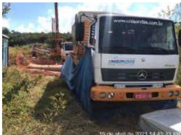
**Foto 94** – Caminhão do provedor com lonamento para proteção do solo. (Data:15/04/2021)
