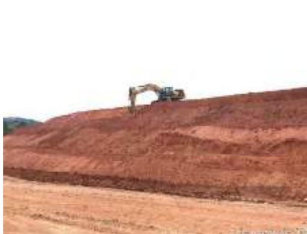
**Foto 235** – Compactação de taludes bota espera. (Data:05/03/2021)
