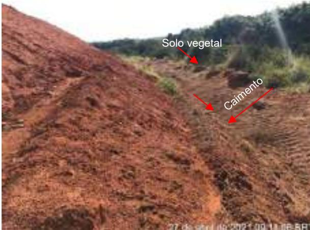
**Foto 254** – Vista para as medidas de proteções no Bota Espera, tais como caimento do terreno, canaleta, leiras e recobrimento com material vegetal. (Data:27/04/2021)
