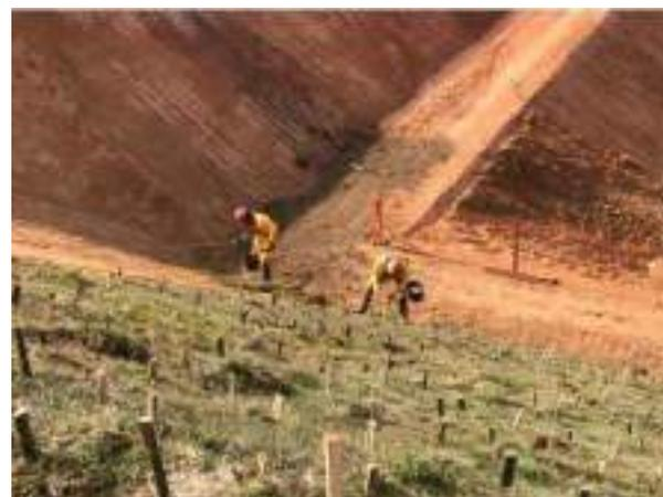
**Foto 271** – Equipe devidamente treinada aplicando grama em placa nos taludes do vertedouro. (Data: 27/05/2021)
