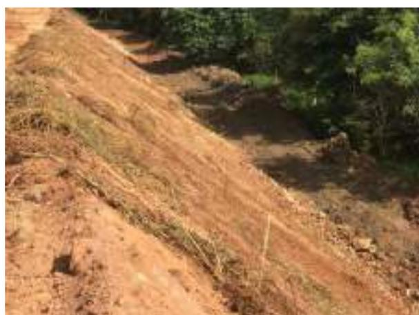
**Foto 239** – Solo vegetal para proteção de talude.
