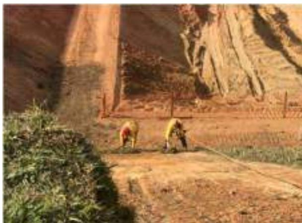
**Foto 270** – Equipe devidamente treinada aplicando grama em placa nos taludes do vertedouro. (Data: 27/05/2021)
