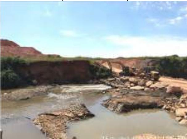
**Foto 244** – Enrocamento de pedra na margem do rio camanducaia próximo a passagem molhada. (Data: 15/04/2021)
