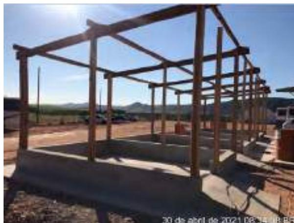
**Foto 70** – Baía para armazenamento de produto químico em fase de implantação no canteiro Industrial. (Data:30/04/2021)
