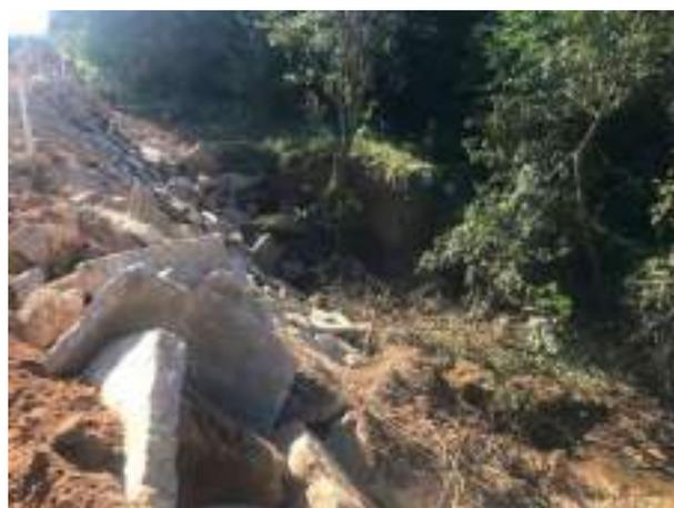
**Foto 241** – Utilização de material de demolição para drenagem. (Data:23/03/2021)
