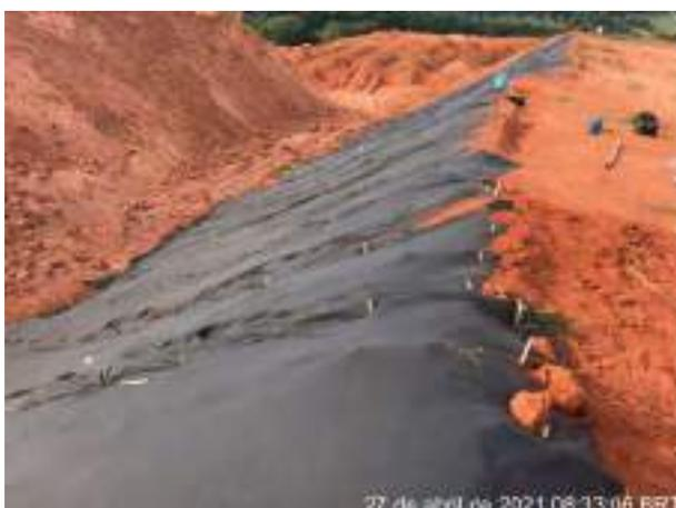
**Foto 250** – Manta geotextil no bota espera para separar colúvio do material residual. (Data: 27/04/2021)
