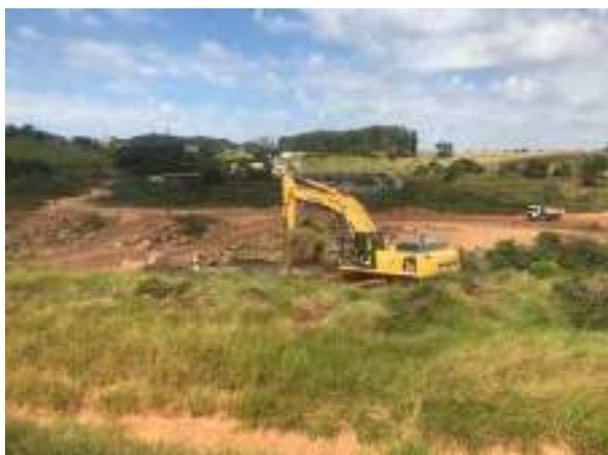
**Foto 260** – Reafeiçoamento da margem do rio com material vegetal. (Data:18/04/2021)
