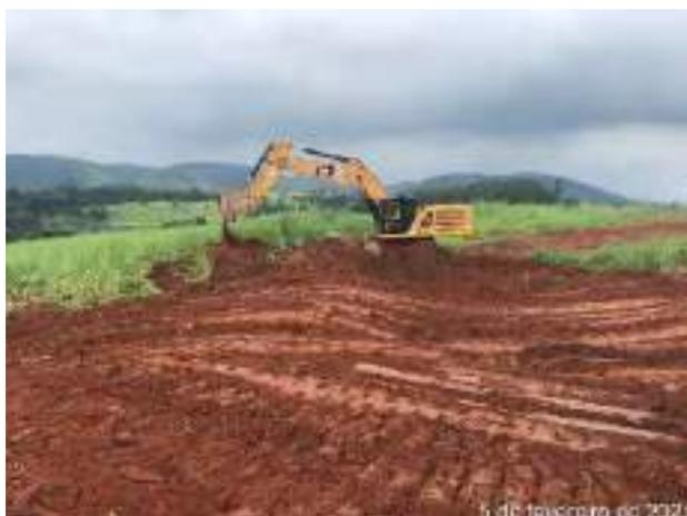
**Foto 224** – Limpeza e ajuste no terreno para disciplinamento das águas pluviais MD Bota espera. (Data:05/02/2021)
