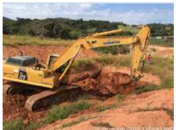
**Foto 247** – Compactação de taludes bota espera. (Data:16/04/2021)
