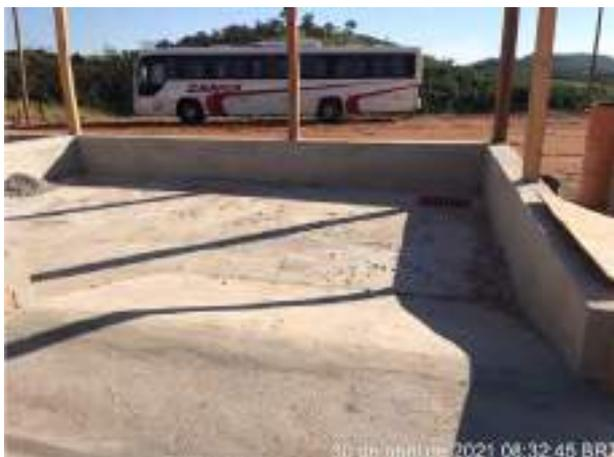
**Foto 69** – Baía para armazenamento de produto químico em fase de implantação no canteiro Industrial. (Data:30/04/2021)
