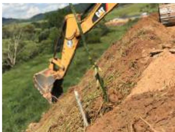
**Foto 227** – Aplicação de topsoil com gramíneas no nos taludes do Bota Fota. (Data:19/02/2021)
