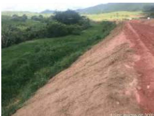
**Foto 232** – Cobertura de talude com material vegetal. (Data: 10/03/2021)
