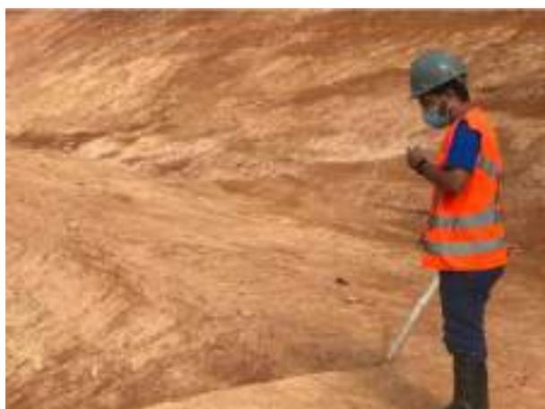
**Foto 252** – Avaliação de solo do talude do vertedouro para verificar qual tipo de cobertura vegetal melhor se aplica no local.
