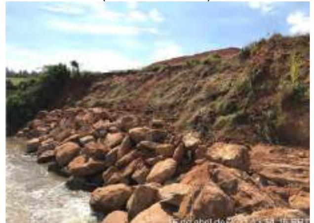
**Foto 245** – Enrocamento e aplicação de solo vegetal para recomposição da margem do rio Camanducaia. (Data: 15/04/2021)
